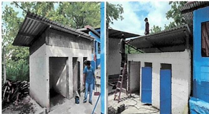
Foto1: Remodelación de baños, cambio de estructura metálica y lámina, pintura de baños.
